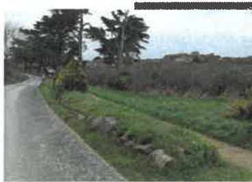
État actuel des talus séparant le sentier et la route (rue Aimée Fournier)
