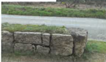
Muret déjà réalisé sur la partie sud de la rue Aimée Fournier
