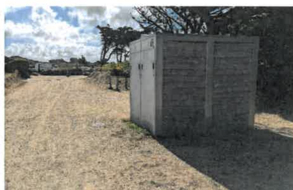
Existant – sanitaire sans muret.
