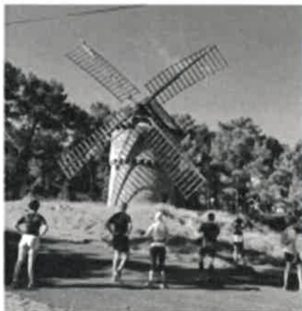
Le projet : la restauration des ailes du moulin et la création de deux places de stationnement.
