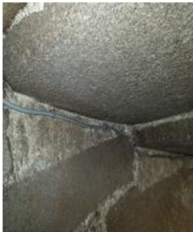
Câbles dans l'escalier d'accès à la tribune
