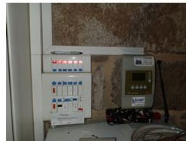
Commandes d'éclairage présent dans le TGBT
