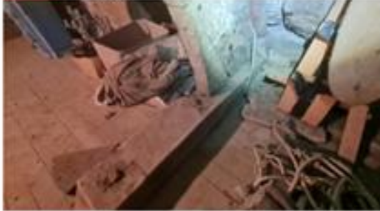
60 Photo 60 Semelles fixées aux Poutres de plancher
