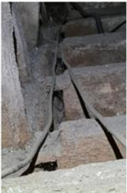
Photo 14 Vue d'ensemble du déboîtement de blochet
