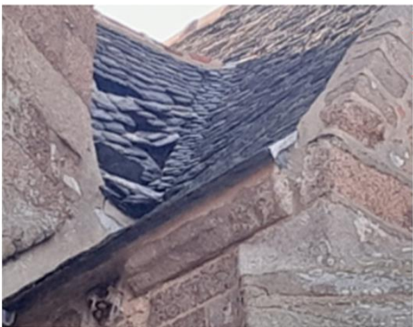
Raccord de toit bâcher au niveau du clocher
