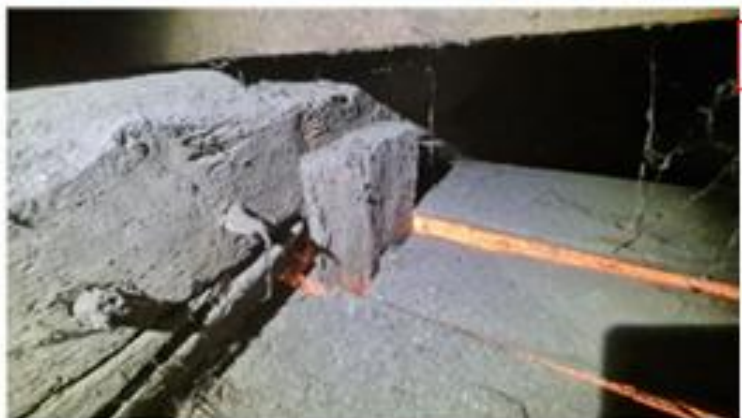
Photo 35 culot 3 affaissé de plusieurs centimètres, les assemblages ne font plus leur rôle de tenue mécanique
