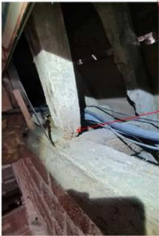
Photos 16 Sur les photos, on remarque que certaines cerces basse qui ont un rôle de jambe de force en plus de reprise lambris, ne sont plus assemblées aux corniches, certaines sont toujours en pression sur les corniches, ce qui montre la compression de cette éléments sur la corniche. Certaines cerces sont libre de mouvement du la leur dégradation [ soit des futures translations à l'avenir sur ces parties]
