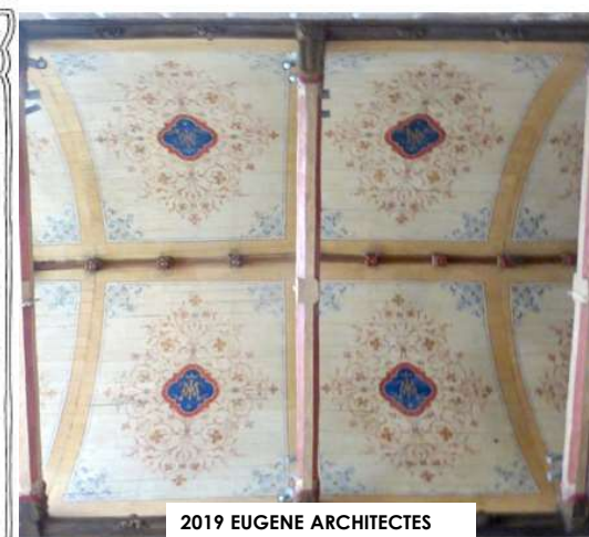
Vue de la voûte lambrissée de la nef avec son décor polychrome du XIX ème siècle et ses entrants à engoulants venant reposer sur une corniche en bois sculptées marquant la limite entre le mur et la voûte.
