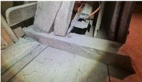
58 Photo 58 Les pieds de ferme sont repris par des semelles fixés aux poutres de plancher (intervention en 1976)
