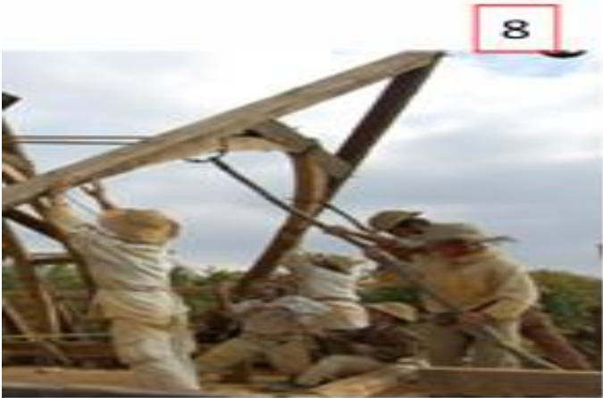
Photo chantier charpente chapelle de Guédelon. Exemple des charpentiers chevronniers du Guédelon
