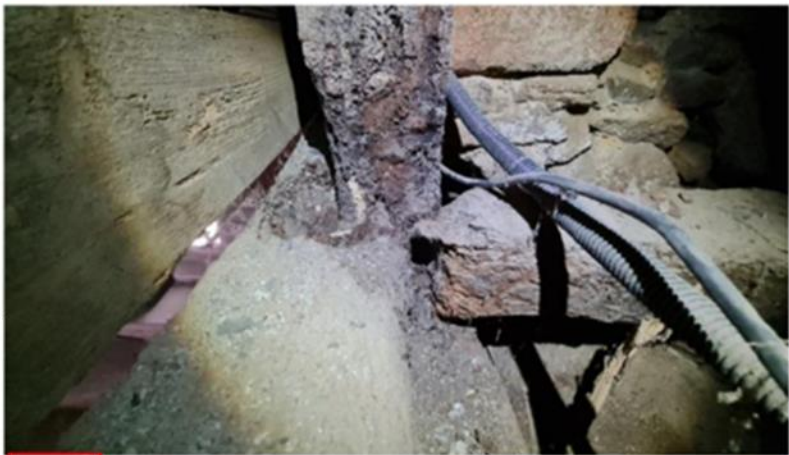
Photo 19 assemblage cerce/blochet HS
