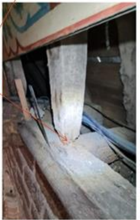
Photos 16 Sur les photos, on remarque que certaines cerces basse qui ont un rôle de jambe de force en plus de reprise lambris, ne sont plus assemblées aux corniches, certaines sont toujours en pression sur les corniches, ce qui montre la compression de cette éléments sur la corniche. Certaines cerces sont libre de mouvement du la leur dégradation [ soit des futures translations à l'avenir sur ces parties]
