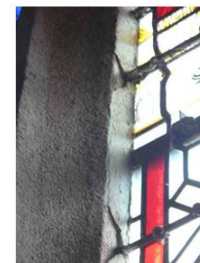
Calfeutrements soufflés dus à l'oxydation des vergettes
