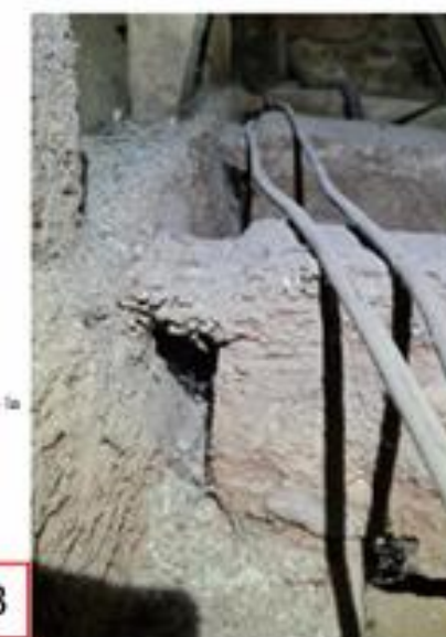
Photo 12 Déboisement d'une série de blochet Au niveau d'assemblage tenon/mortaise Jonction queue d'aronde blochet/sablère libre de mouvement suite au dégradation de sablière
