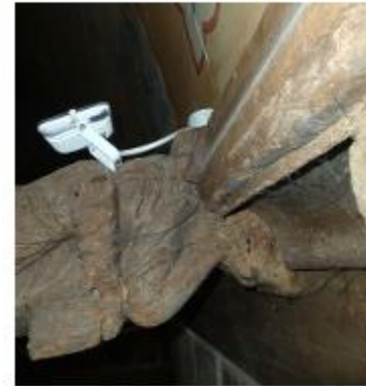
Éclairage voûte côté Nord
