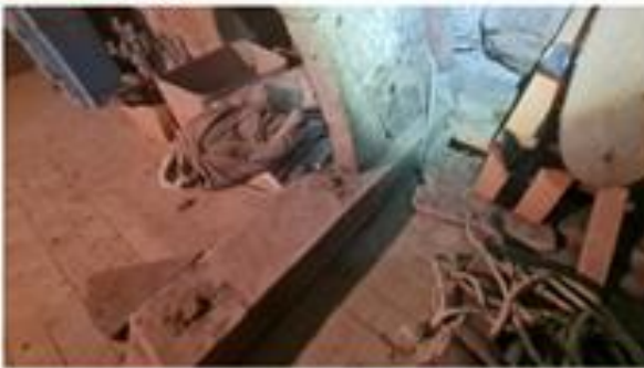
58 Photo 58 Les pieds de ferme sont repris par des semelles fixés aux poutres de plancher (intervention en 1976)
