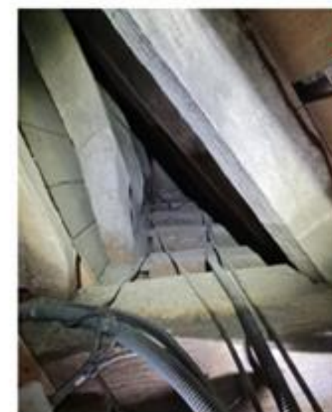
Photo 12 Déboisement d'une série de blochet Au niveau d'assemblage tenon/mortaise Jonction queue d'aronde blochet/sablère libre de mouvement suite au dégradation de sablière
