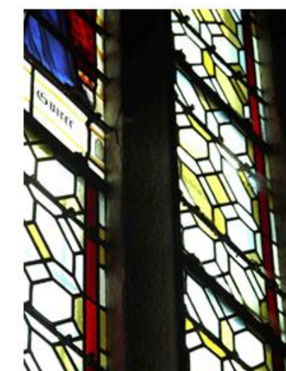
Calfeutrements soufflés dus à l'oxydation des vergettes
