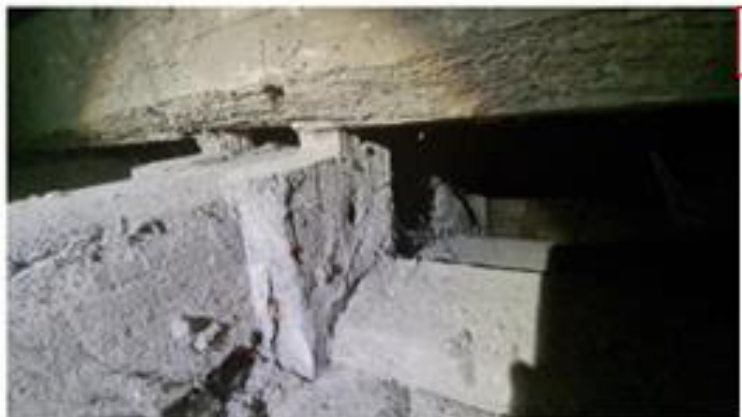
Photo 36 culot 3 affaissé tenon se dégage de la mortaise
