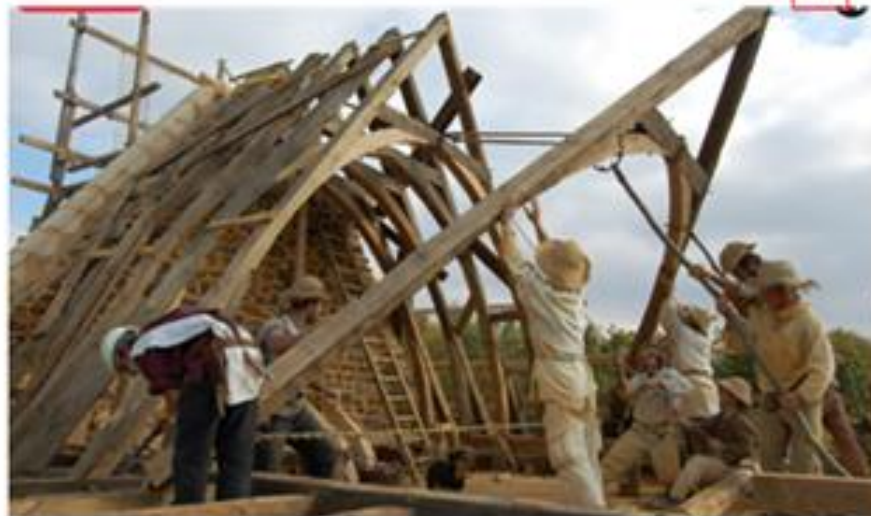
Photo chantier charpente d'été de Guédon exemple des charpente-dite chevrons formant ferme
