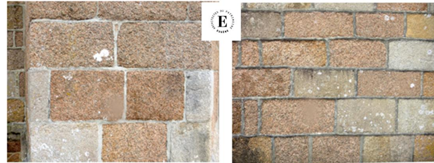
Vue des différentes typologies de joints présentes sur la chapelle. A gauche un joint «classique» en mortier hydraulique, à droite une épais joint ciment dit «joint beurré».
