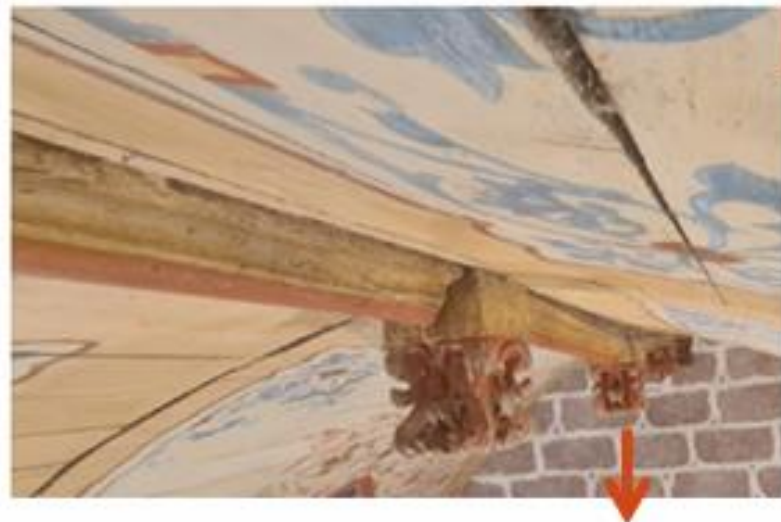
Photo 32 on remarque un fort affaissement du 3 ème culot en partant du porche Ouest
