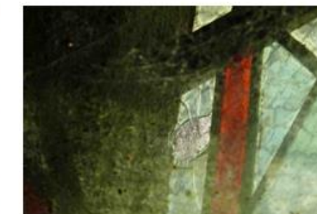
Calfeutrements soufflés dus à l'oxydation des vergettes
