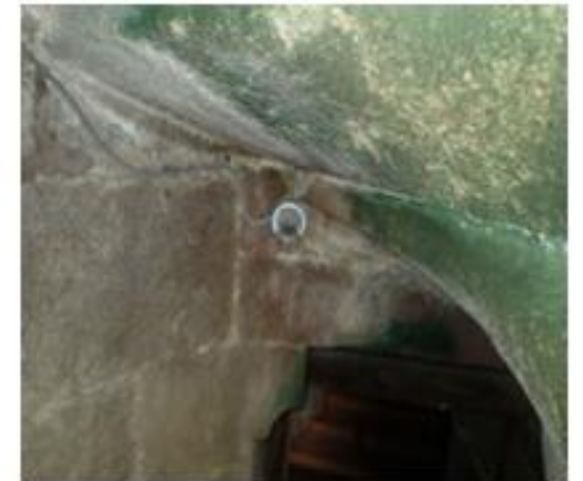
Éclairage escalier accès tribune.
