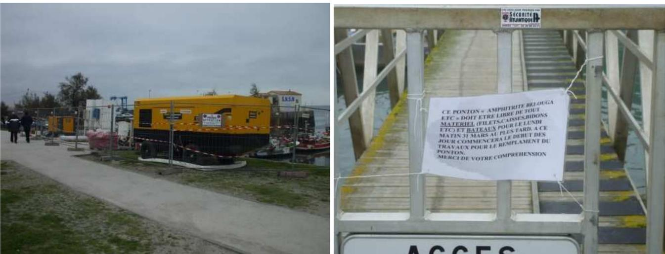
**Figure 62 : Exemples d'information et de limitation de la zone relative au chantier.**
