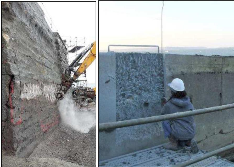
**Figure 14 : Exemple fraisage mur béton, jetée de Bréhec (22) – Réalisation engravure pour raccordement, Port Lazo (22)**
