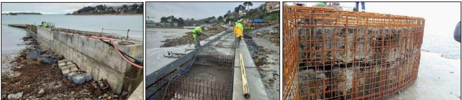
**Figure 16 : Exemple ancrage, ferrailage, coulage carapace béton - voiles + dalle par passes alternées - cale Trestraou / musoir Port de Guidel (56)**
