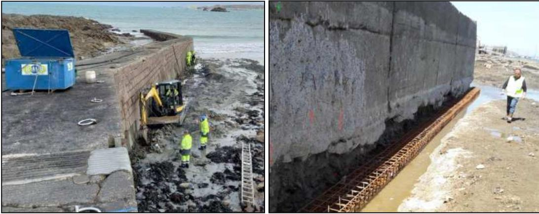
**Figure 15 : Exemple de réalisation de bêche de fondation – Trestraou (22) / Dinard (35)**
