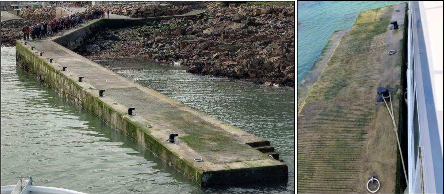
**Figure 20 : Exemple de bollards d'amarrage et organeaux – cale de Trestraou – Perros Guirec**
