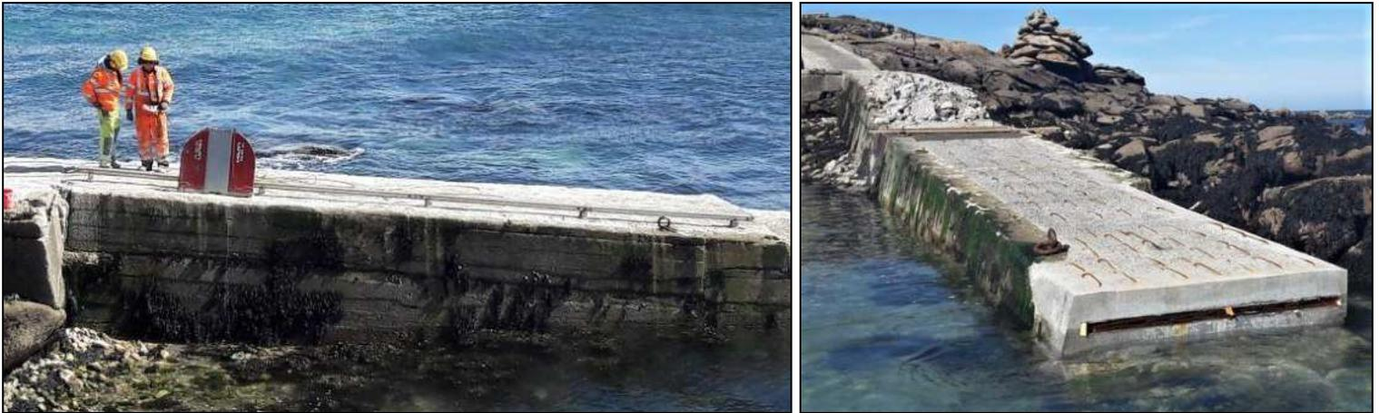
**Figure 17 : Exemple sciage déconstruction et reconstruction avec conservation des mur béton – Cale île Vierge Plouguerneau (29)**
