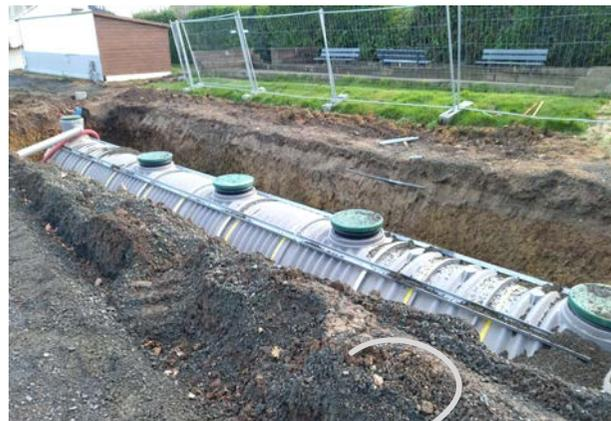
Installation d'une cuve enterrée de 50 m<sup>3</sup> permettant de récupérer les eaux pluviales issues de la toiture du gymnase Yves le Jannou pour l'arrosage du terrain d'honneur, des arbres dans la ville et le remplissage de la balayeuse.
